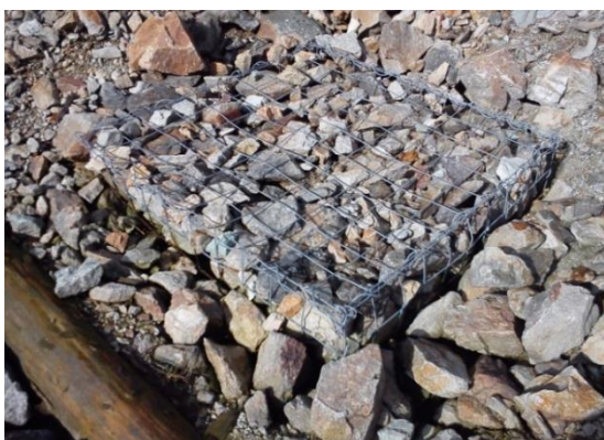
Obr. 1 Fe^0 -bariéra na haldovom poli Podlipa
