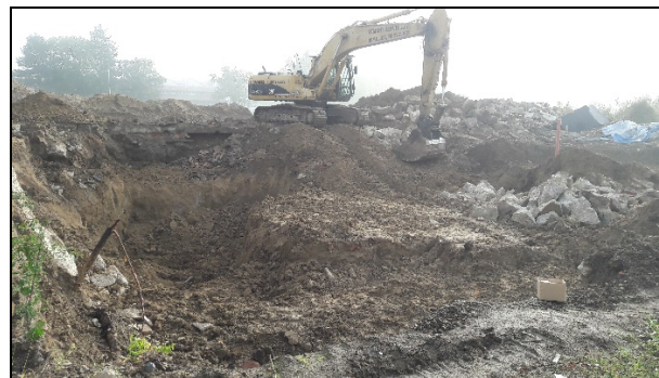
Obr. 3 Odtěžby kontaminované zeminy nacházející se v místě pod budovou bývalé chromovny
