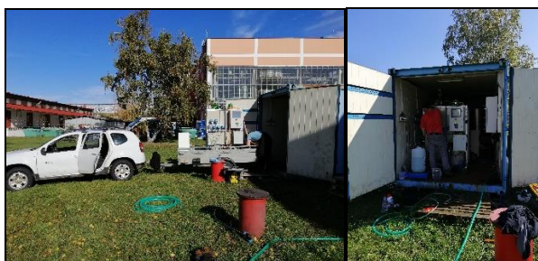
Obr. 4 Instalace technologie na lokalitě
