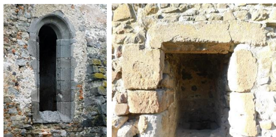
Obr. 3 a) Pieskovcové ostenie gotického okna kostola a b) niky v múre opevnenia
