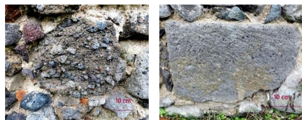
Obr. 4 Typy pyroklastického stavebného materiálu: a) hrubozrnný a b) jemnozrnný
