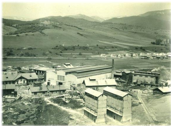
Obr. 1 Pohľad na spracovanie antimónovej rudy s vysokým obsahom As v Kovohutách Vajsková, okr. Brezno.
