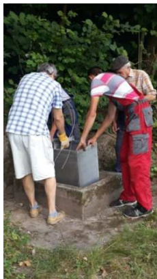
Obr. 2 Krupina, Kňazová dolina 1209, studňa č. 2, osádzanie koša do studne (foto: Cvečková, 2015)
